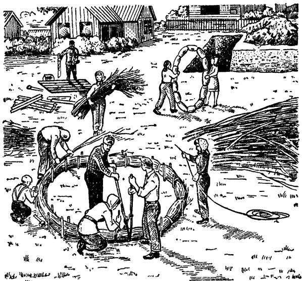
Рис. 29. Устройство кольцевых фашин из хвороста и камыша (такой шаблон пригоден для одновременной вязки двух арочных фашин)
