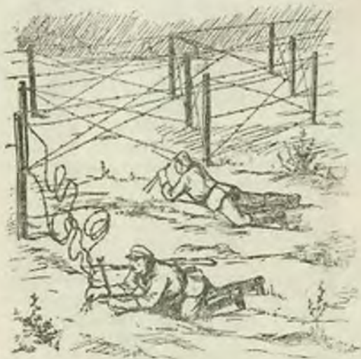
Рис. 10. Освобождение прохода в проволочной сети
